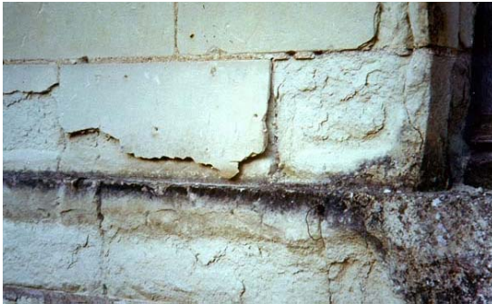
Figure 1 : Altération en plaques (château de Blois) (Rautureau [3])
