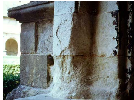
Figure 2 : Désagrégation sableuse (abbaye de Fontevraud) (Rautureau [3])
