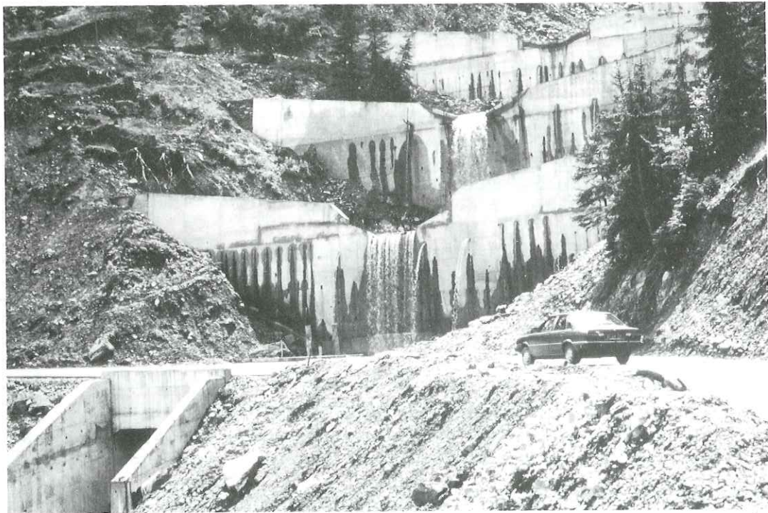
Photo 1 : Implantation d'ouvrages "en escalier"
