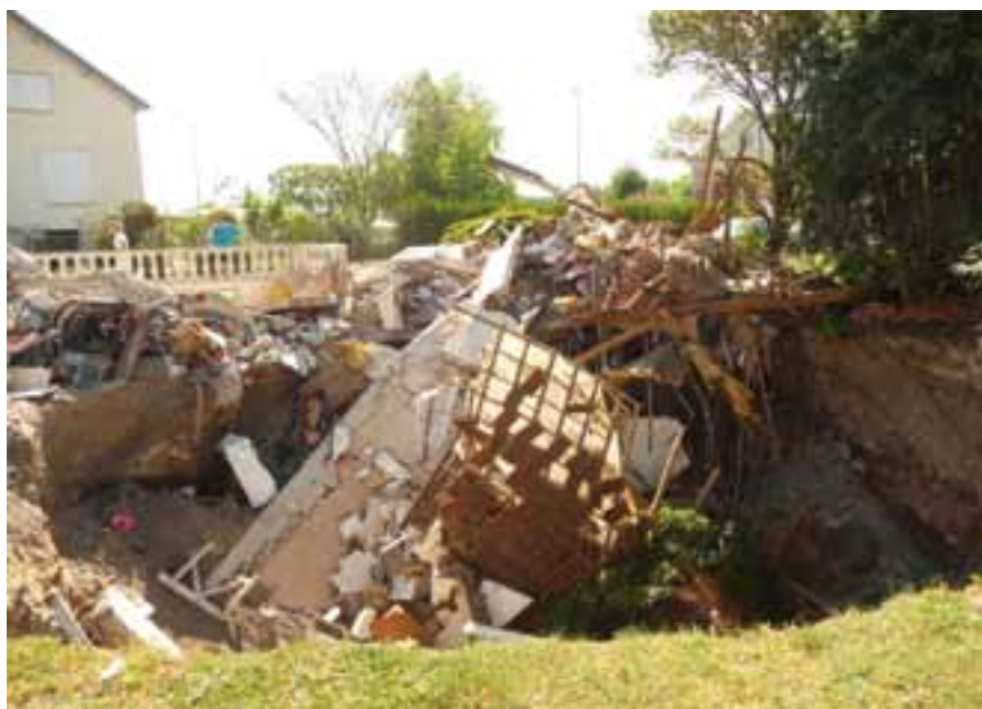
▲ Photo 2 : Effondrement à Saint-Pryvé-Saint-Mesmin. Le 22 mai 2010 une maison est entièrement engloutie par une « bîme » en liaison avec la circulation souterraine de l'eau de la Loire.
