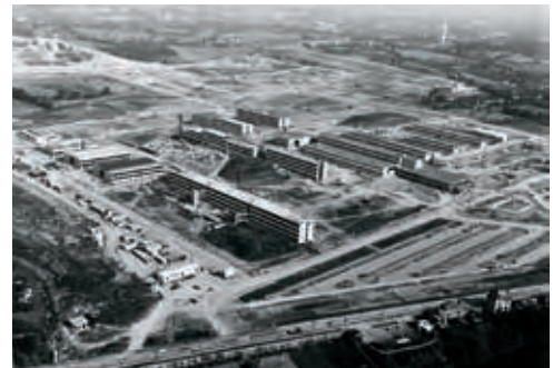
Le chantier du campus de Beaulieu en 1963
