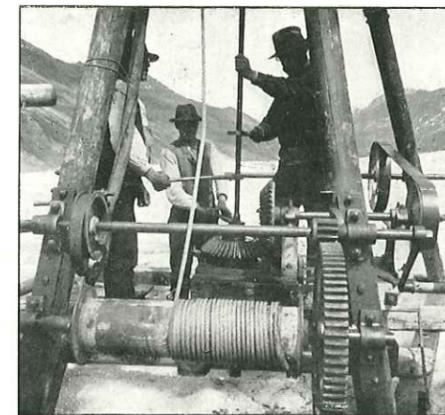
N° 17 Vissage d'un tube. Phot. Flusin
