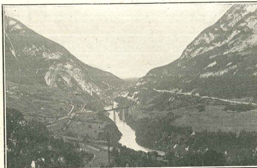
FIG. 25. — LE VIADUC DE LONGERAY
