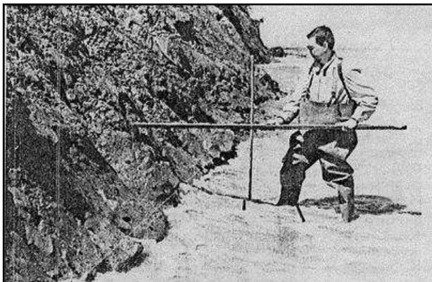
Fig. 4 – Mesure d'érosion à Helen Drive, USA (in Carter & Guy, 1988).
