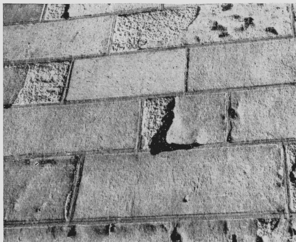
FIG. 4. — Desquamation du tuffeau
