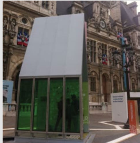
Le pavillon AlgoNOMAD, avec sa biofaçade à micro-algues, exposé pendant la COP21 sur le parvis de l'Hôtel de Ville de Paris dans le cadre de l'exposition "Paris de l'Avenir"
