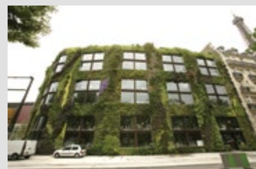
Mur végétal de 800m 2 qui est installé sur la façade du Musée du quai Branly
