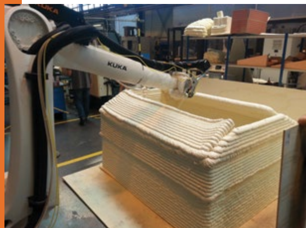
▲ Premier cas d'application concret pour INNOprint 3D : la construction d'un habitat d'urgence en 20 à 30 minutes
