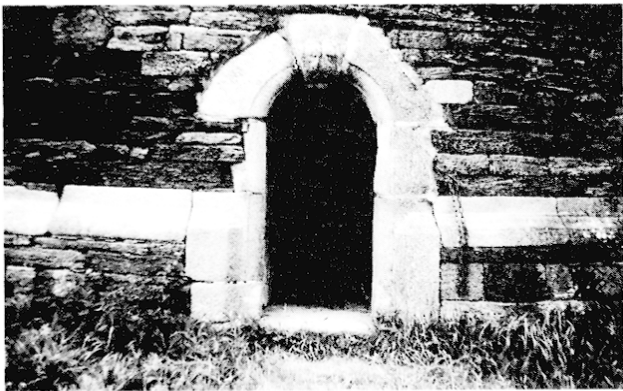
Photo 7: Entrée du colombier de Keranroux en Ploujean (XVI e siècle). Moellons schisteux (Cliché L. Chauris).
