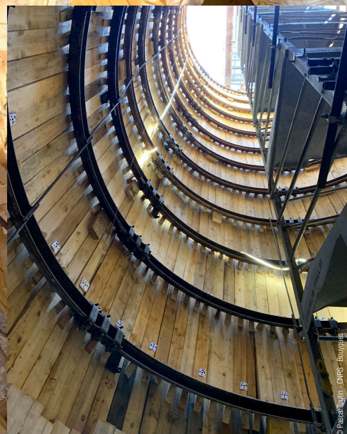
Vue en contre plongée du puits avec l'escalier d'accès à droite. Une fois creusé, le puits a été habillé d'un parement en bois temporaire.
