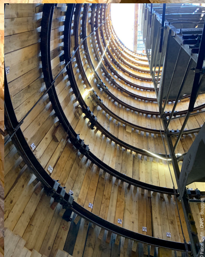
Vue en contre plongée du puits avec l'escalier d'accès à droite. Une fois creusé, le puits a été habillé d'un parement en bois temporaire.
