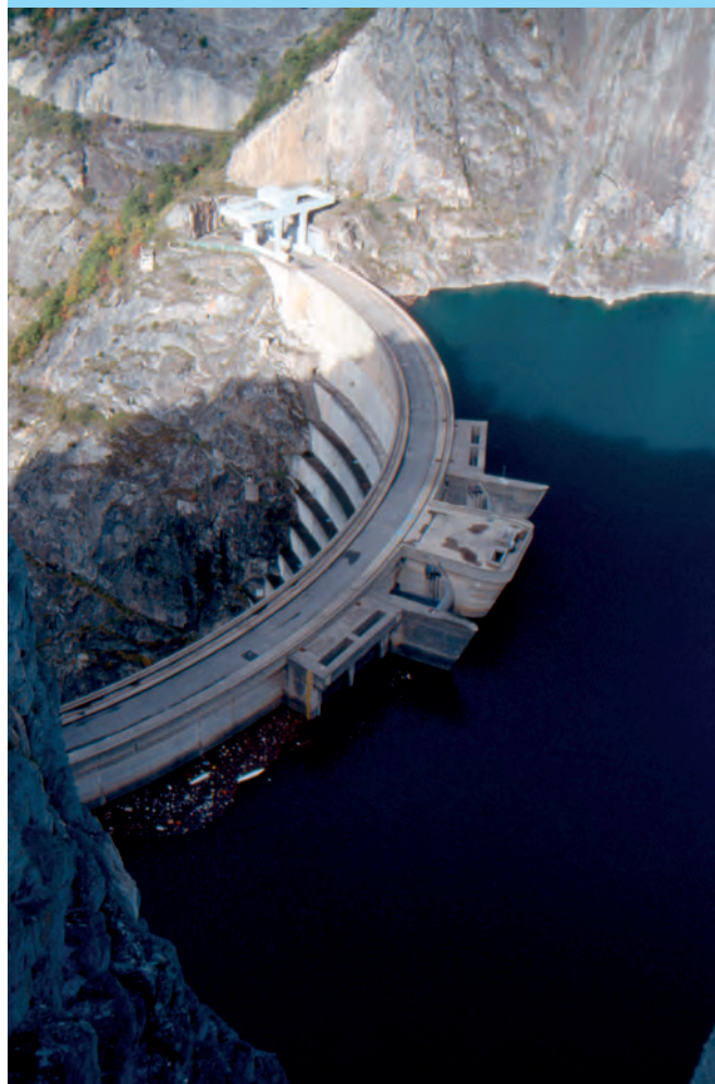
Parement aval du barrage du Monteynard sur la rivière le Drac en Isère, France. Il s'agit d'un barrage de type voûte épaisse en béton, d'une hauteur de 153 mètres et le volume de la retenue est de 275 millions de m 3 . © Philippe BOIS/CNRS Images
